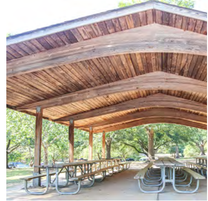
1E Picnic Shelter
